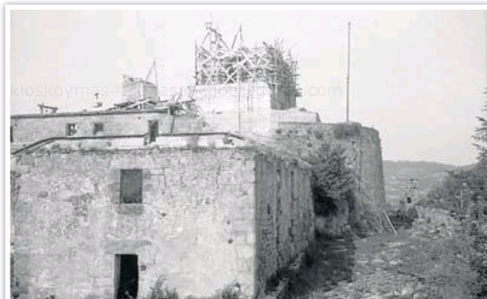
Construcción del monumento al Sagrado Corazón en Urgull. KUTXATEKA
